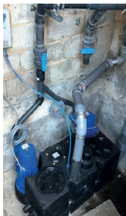
Sanicubic 2 GR được lắp đặt thay cho trạm cũ
