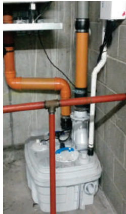
SANICUBIC® 2 VX được lắp đặt trong phòng kỹ thuật
